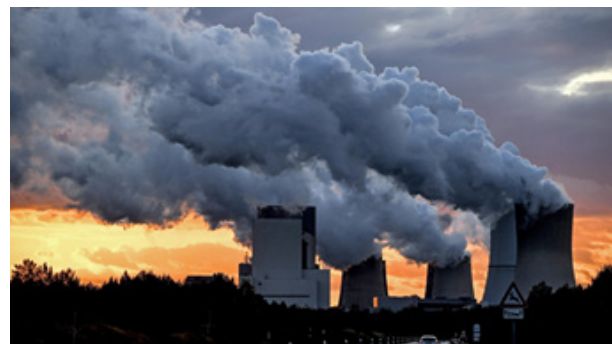
Foto 18. Vapor de agua que emana de varias chimeneas en una planta térmica de Boxberg, en Alemania 7 . La Vanguardia.
