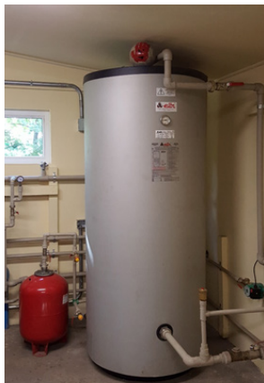
Figura 23. Esquema de estanque de ACS y estanque instalado.
