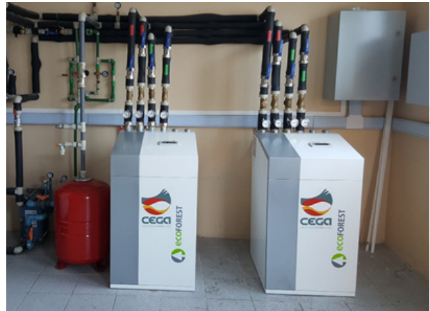
Foto 11. Imagen bombas de calor de proyecto Makay. CEGA.
