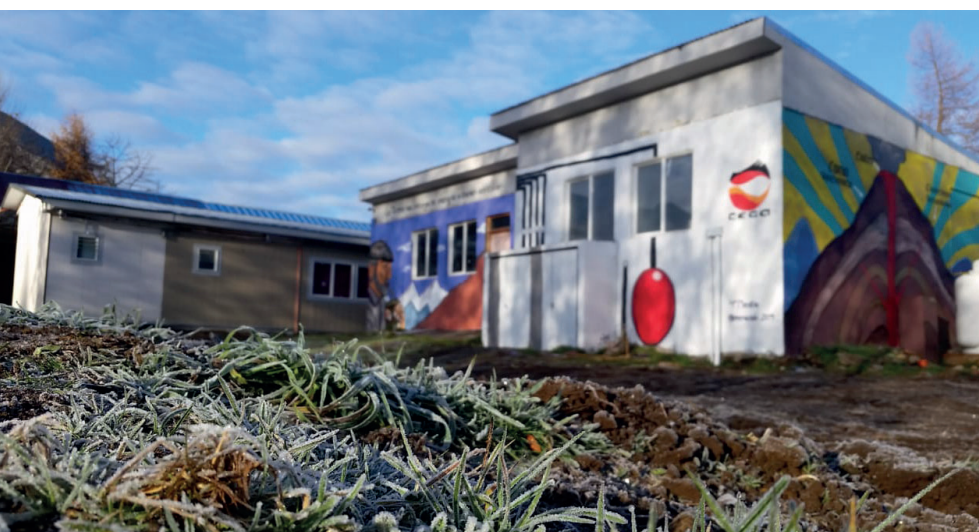
Figura 10. Mural en la sala de máquinas del Liceo Altos del Mackay. Fuente: Archivo CEGA
