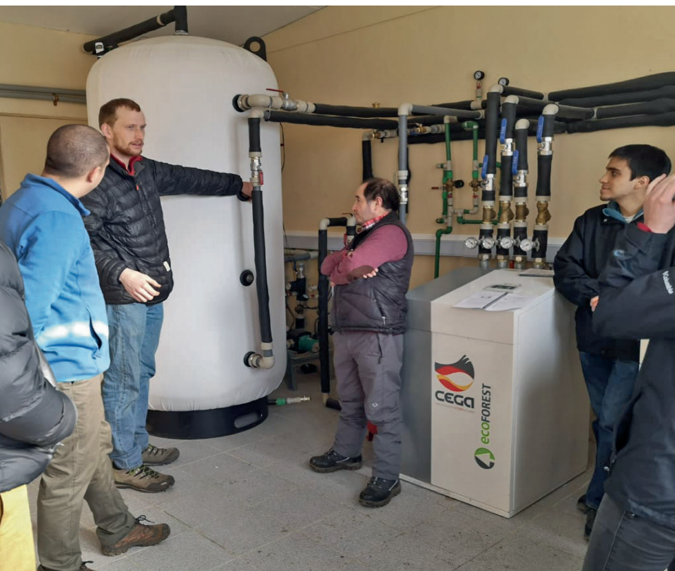
Figura 7. Capacitación del operador Pedro Yañez en el sistema de calefacción con geotermia. Fuente: Archivo CECA.
